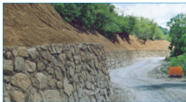
Lavori alluvione - sistemazione Veynes-Crétallaz.
