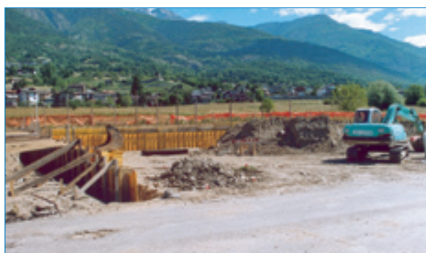
Lavori del campo sportivo.
