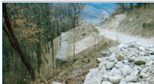
Lavori alluvione - sistemazione scarpate.
